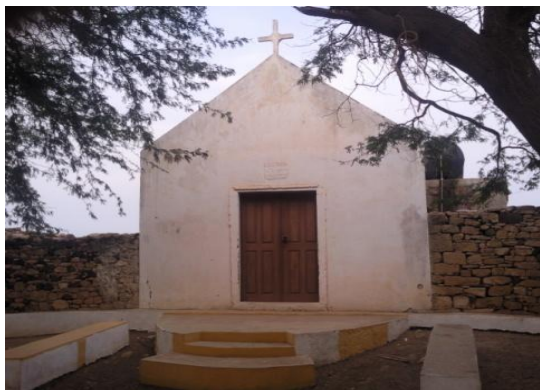
Ilustração 23: Capela de Nossa Senhora do Rosário. Fonte: Autor.
