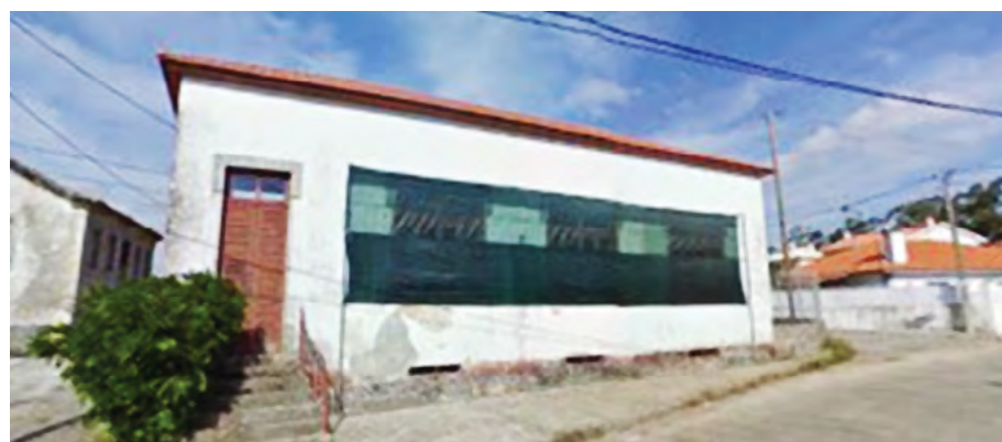
A Escola de Gião, em 2009, em obras de transformação, ainda com a escadaria de entrada.
