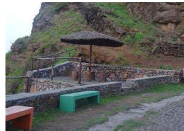
Imagem: Miradouro de Boca Covada, ponto de parada com boa estrutura, com necessidade de algumas melhorias para integração à nova rede.
