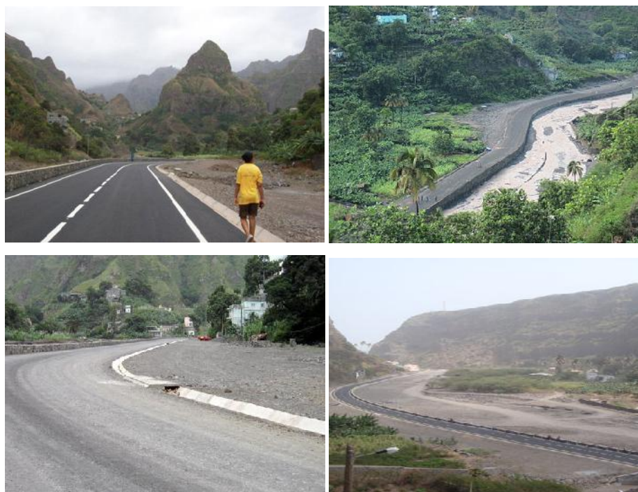
Ilustração 4 - Vale de Ribeira da Torre
